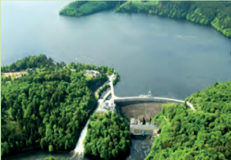
Talsperre Bleiloch mit aktiver Hochwasserentlastung © TLUG 2013, Aufnahme: LaNaServ im Auftrag der TLUG
