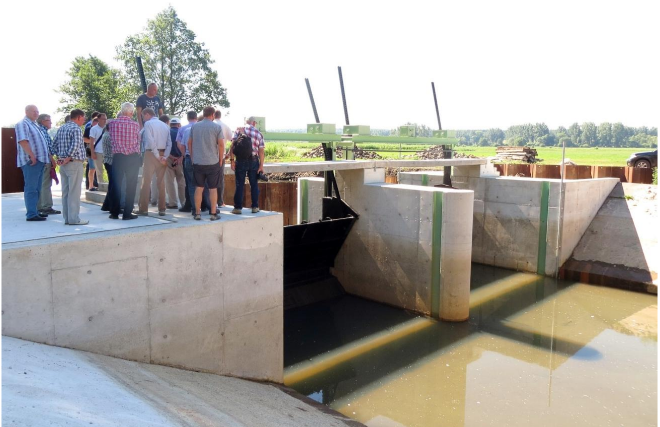
Besichtigung der Wehrbaustelle an der Tollense bei Roidin.
