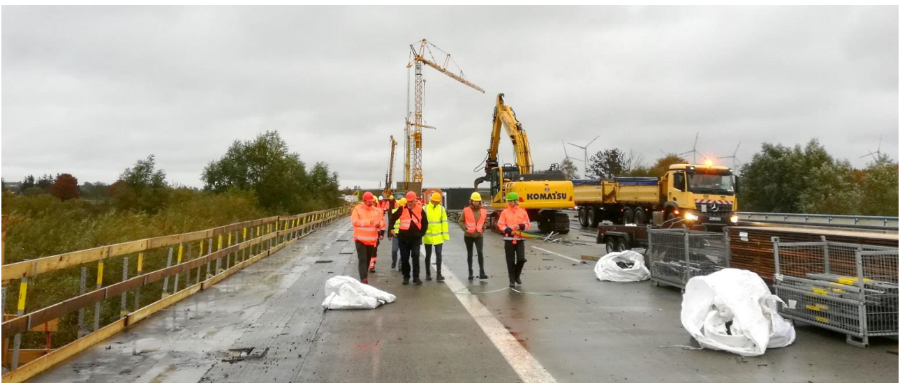
Besichtigung der A20-Baustelle bei Tribsees.
