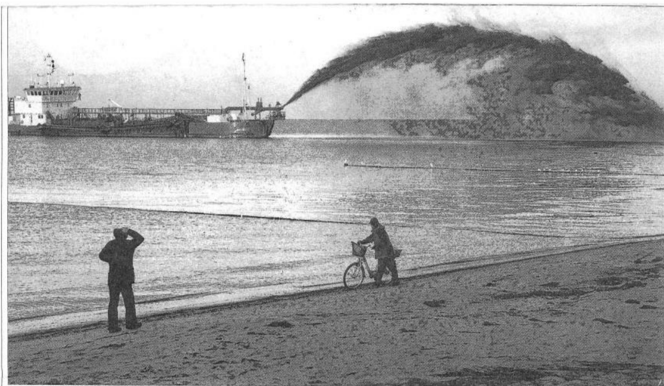
Unverzichtbares Gut für den Küstenschutz: Sand muss aufgespült werden, damit die Dünen halten.
