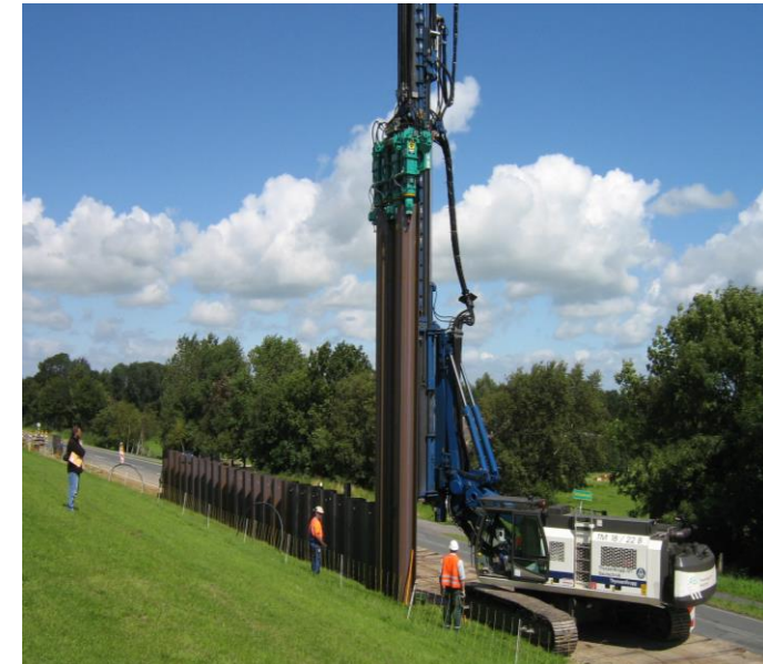
Deichbaustelle Hobenbrake, Spundwandpressen Deichfuß Sicherung Binnendeiches
